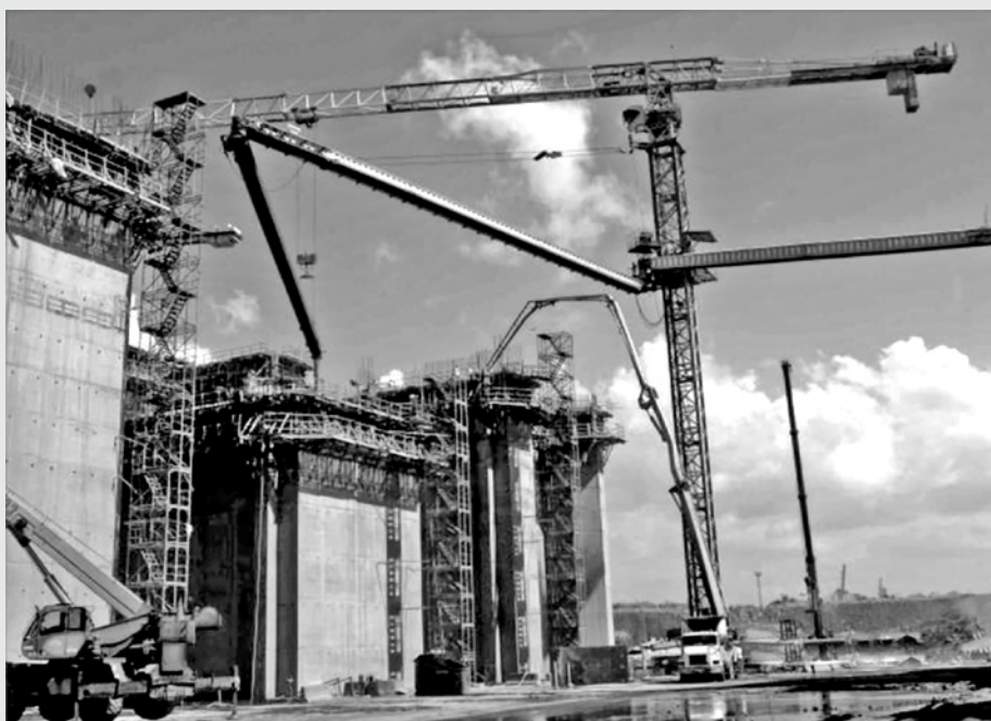
Montagem de correias telescópicas sobre caminhões e sobre a lança de guindastes foi decisiva
