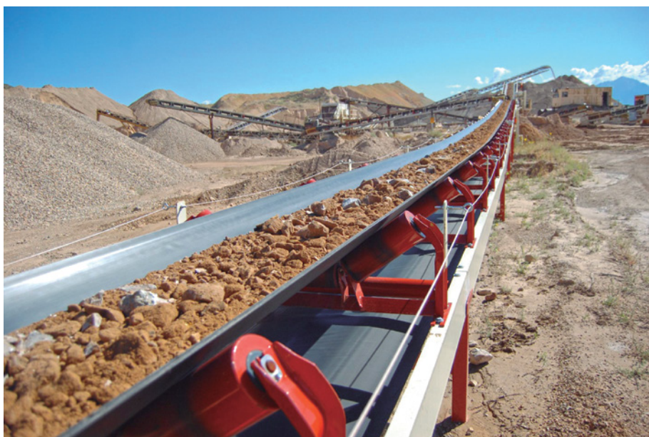
Instalações bem-projetadas eliminam custos com caminhões circulando na planta
