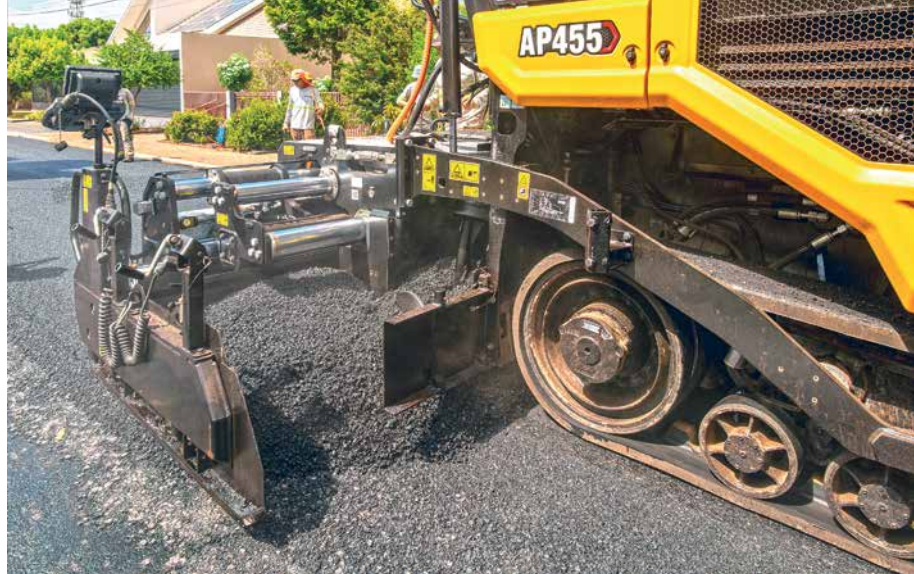
A vibração contribui para o acabamento superficial, enquanto o tamper atua para aumentar a densidade
